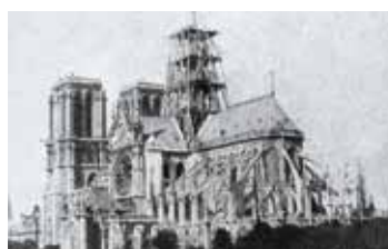
修復中のノートルダム大聖堂 (1859) それまで70年間、尖塔部分はない状態だった
