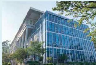
[写真1] 中央図書館外観
