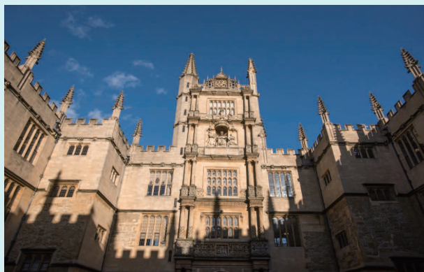
[写真1 ボドリアン図書館外観]
